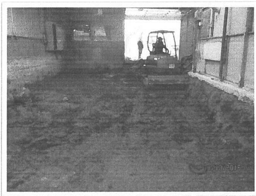
Photographie 2 : Travaux de réhabilitation réalisés à l'intérieur de l'atelier de carrosserie. Vue vers le sud-est.
